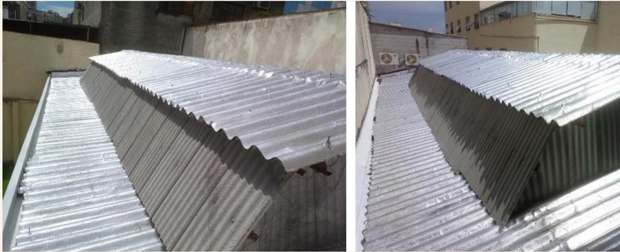
No mês de março, foi realizada a impermeabilização do telhado da sede em Santana. Foram substituídas mais de 30 telhas e todo o telhado recoberto com manta asfáltica, assim como limpeza e tratamento das calhas.
